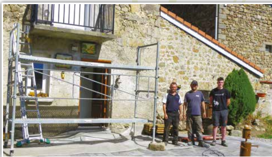
Chantier à Tirepeyre
