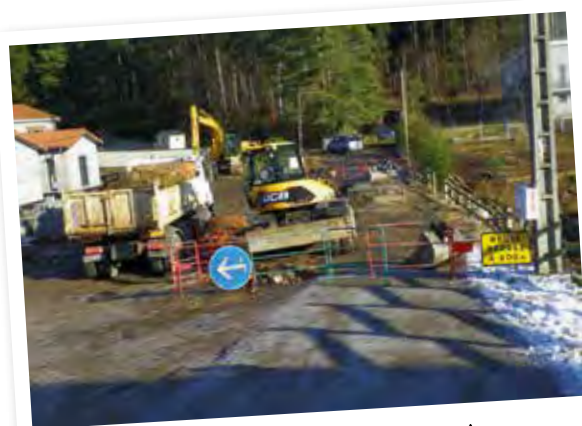
Travaux Le Bois de la Faye
