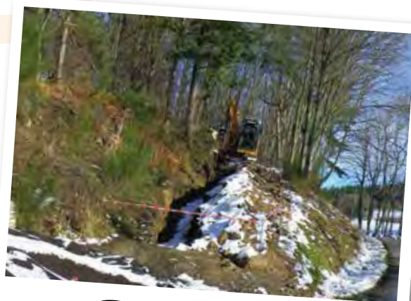
Travaux La Fayolle
