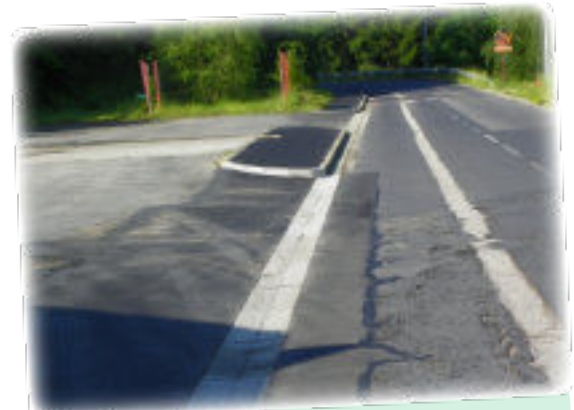
Travaux à Barthou
