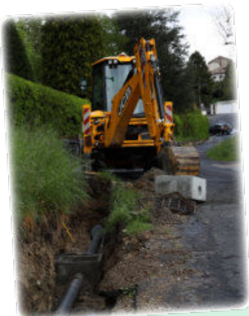
Travaux Rue du Stade
