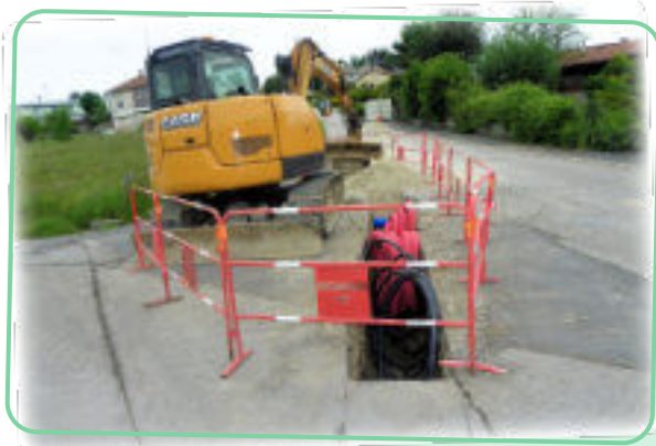
Prolongement des réseaux secs et humides
