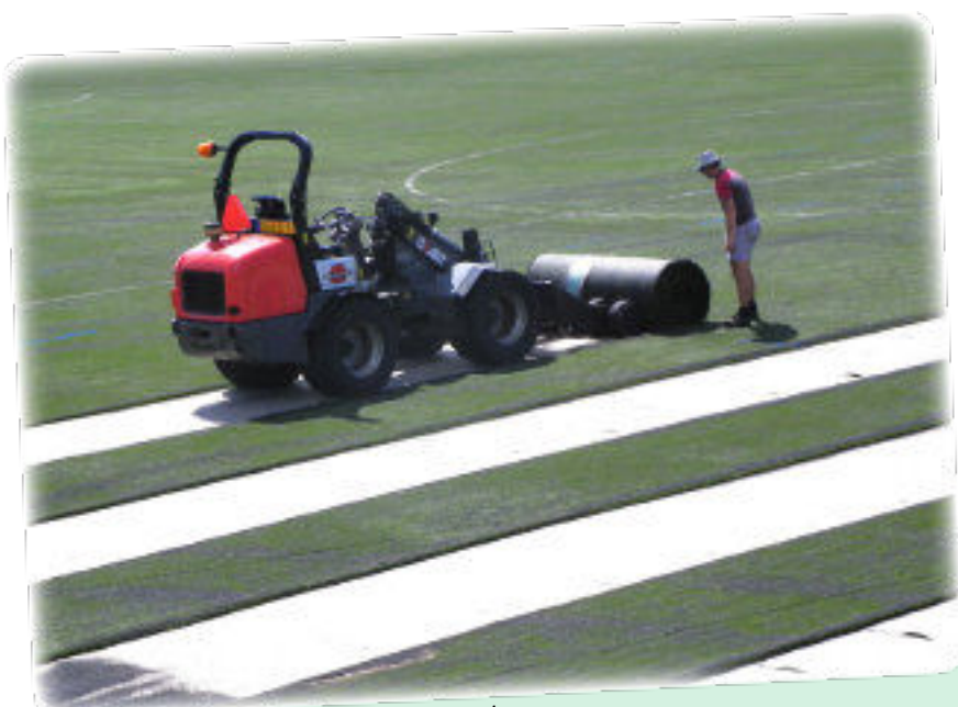
Découpage de l'ancienne pelouse et enroulage
